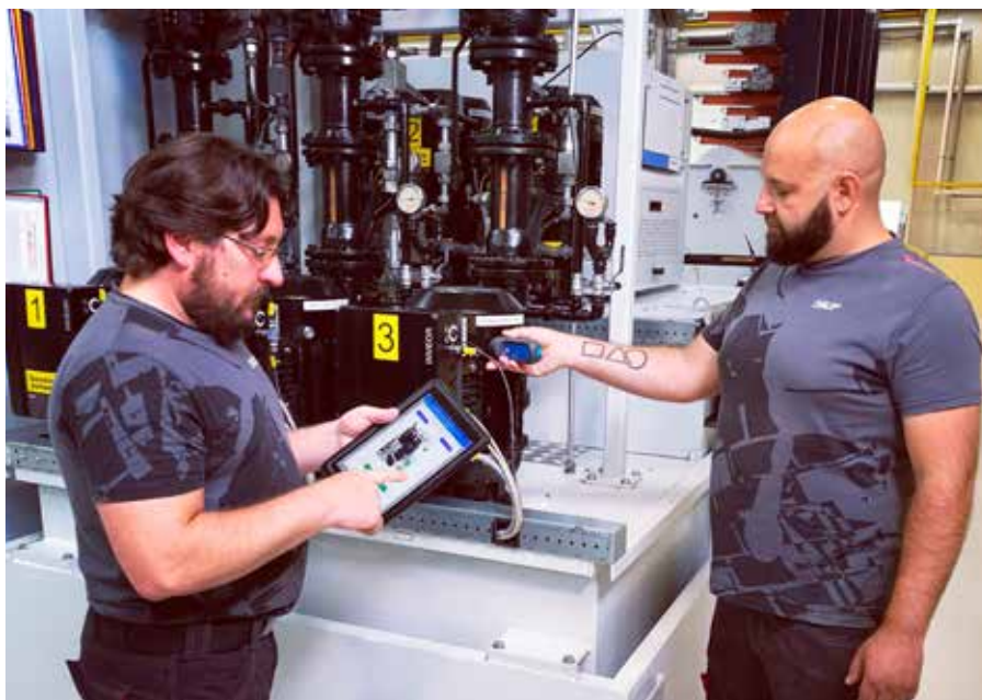
Údržbáři v chodovském závodě při pochůzkách monitorují stav strojů pomocí přístroje QuickCollect
