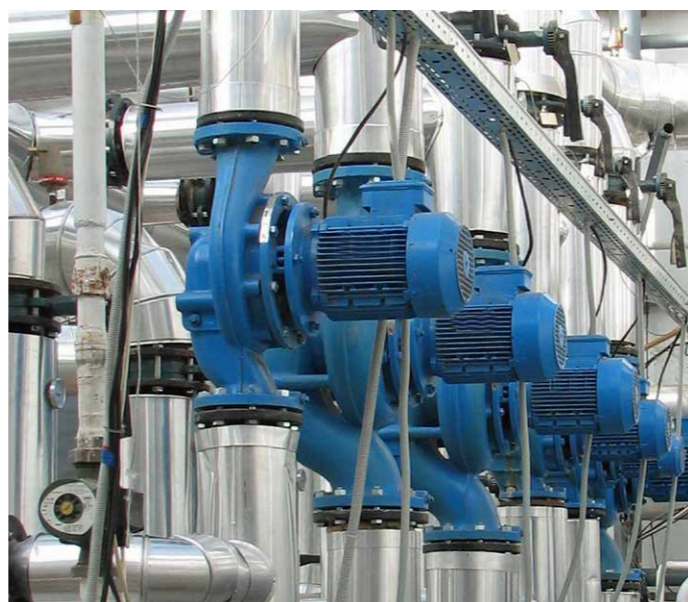
Stromsparer: Dank SKF INSOCOAT Lagern mit keramischer Schutzschicht oder Hybridlagern mit keramischen Wälzkörpern (rechts) können Pumpen und Gebläse mit drehzahl geregelten Antrieben ausgestattet werden, was den Energieverbrauch um bis zu 30 Prozent senkt.
