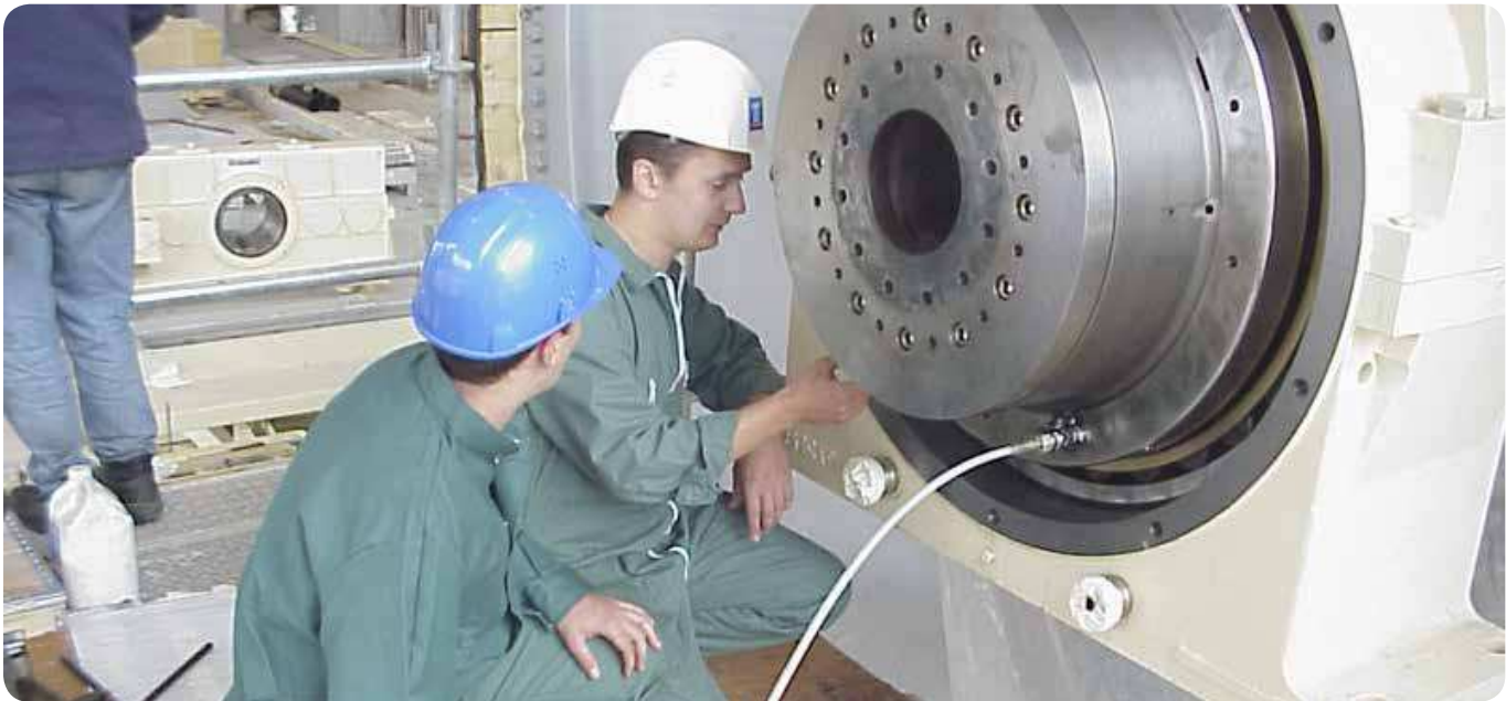
Montage d'un roulement à rouleaux toroïdaux CARB sur un cylindre Yankee, selon la méthode par enfoncement axial SKF.
