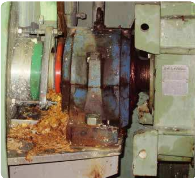
Fig. 6 – Fibres qui s'échappent du presse-étoupe sur une lessiveuse de pâte. Remarquez la protection supplémentaire à l'avant du palier pour protéger l'étanchéité du palier
