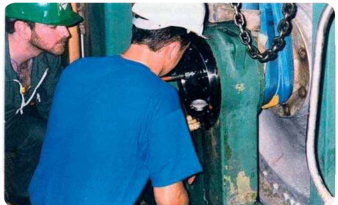
Fig. 2. Le premier CARB™ monté en France à l'usine International Paper Saillat selon la méthode par enfoncement axial SKF. L'auteur est à gauche sur la photo.
