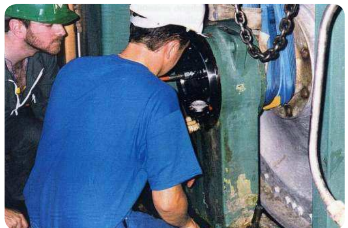
Fig. 2. El primer rodamiento CARB montado en Francia. Esto se realizó mediante el método de calado de rodamientos SKF Drive-up en International Paper Saillat. El autor aparece a la izquierda.
