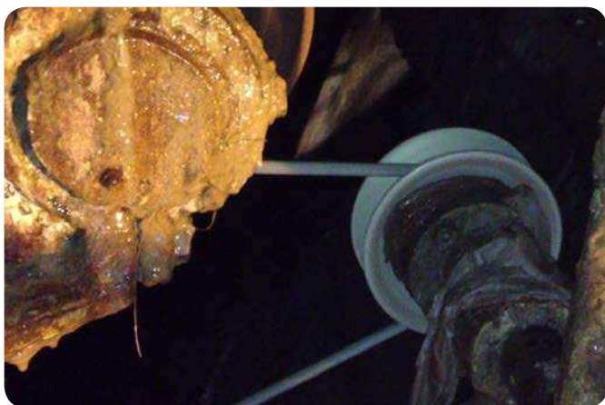
Fig. 10 Unidad de polea para cuerda SKF de nueva generación en funcionamiento.
