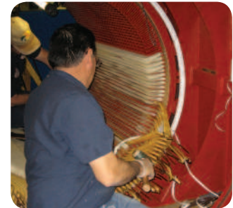
Réparation du bobinage d'un moteur
