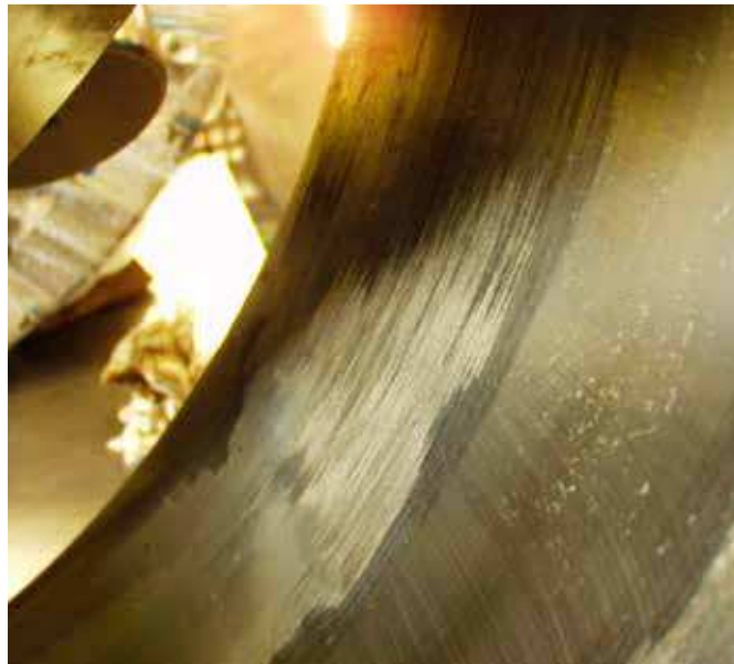
Fig. 9 : Trace de grippage en entrée de la zone chargée d'un roulement de rouleau de presse.
