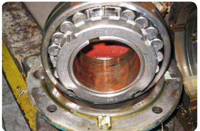
Fig. 11 Corrosión por contacto en el agujero de un manguito de fijación de un rodamiento de rodillos de fieltro de la sección de secado como consecuencia de un ajuste insuficientemente apretado en relación con la carga.
