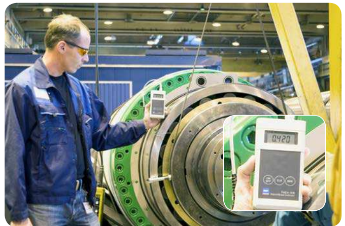
Fig. 4 El dispositivo portátil muestra 0,420 y el técnico de Metso se apresta a apagar la bomba de aceite neumática conectada a la tuerca hidráulica HMV.
