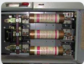
Desconexión del fusible
